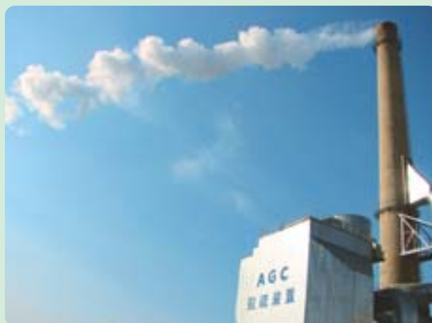
脱硫装置で硫黄分を除去して排出(旭硝子特種玻璃(大連)社)
