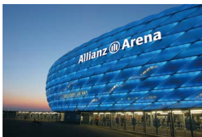
サッカースタジアムのフッ素樹脂フィルム
