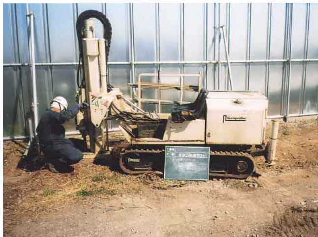
土壌ボーリング調査
