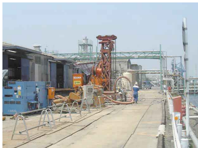
千葉工場の遮水壁設置工事
