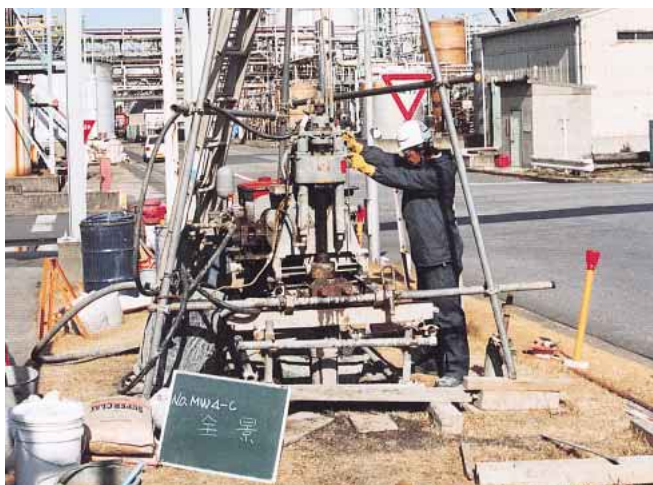
千葉工場の土壌ボーリング調査
