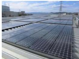
化学強化特殊ガラス Leoflex<sup>®</sup>により、パネル重量が従来品の約半分と軽量であり、設置のための補強工事が不要。設置コストの削減、設置場所の広がりにも貢献。
